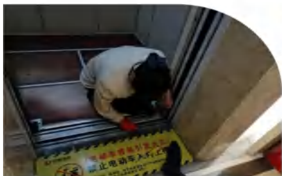
清掏电梯缝隙
