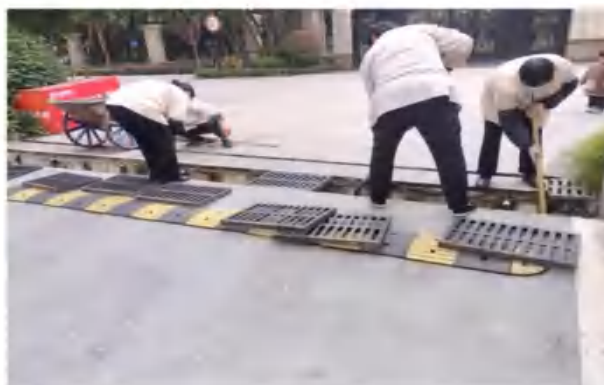
清理地面排水沟杂物
